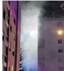
Die starke Rauchentwicklung ist hier deutlich zu sehen. BILD: FEUERWEHR KETSCH
